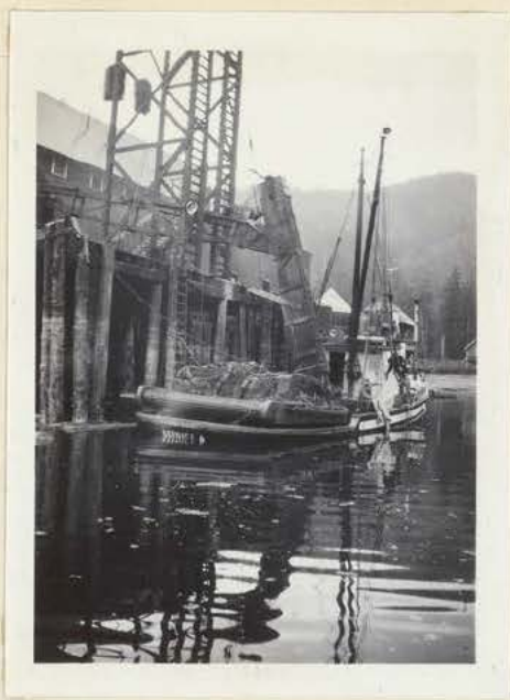
Fig. 9. Purse seiner discharging herring at an Alaskan plant.
