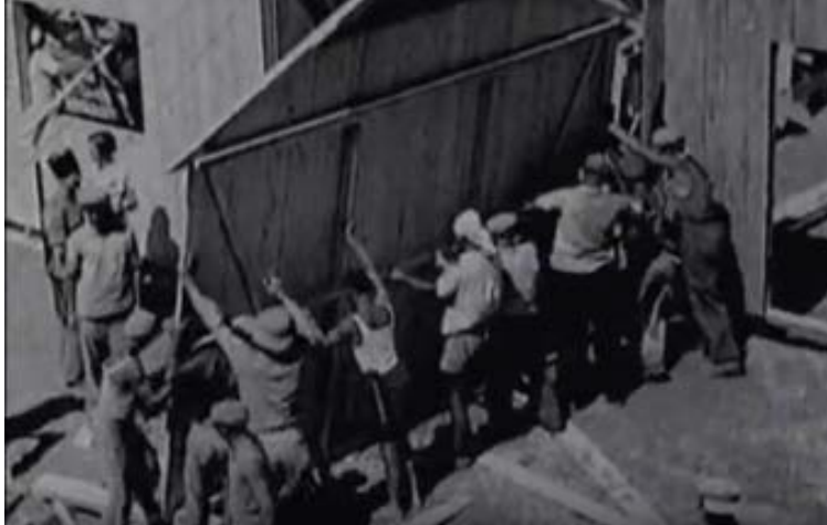
Figure 29. Baruch Agadati ( The Establishment of Ein Gev ). Zionist pioneers install a wall in Ein Gev's Wall and Tower structure, 1937.
