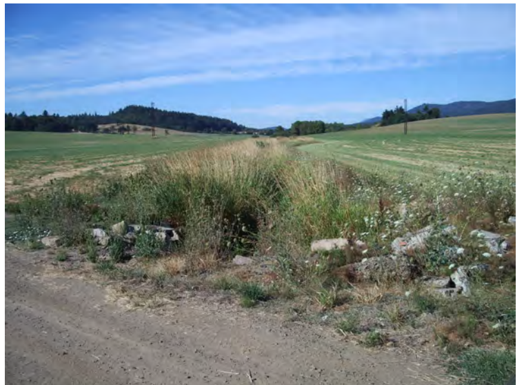
Site 4: Drainage ditch (Station 100+00).
