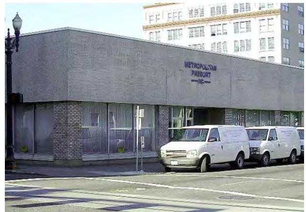
METROPOLITAN PRESORT (NW 10 TH AVE./GLISAN ST.)
